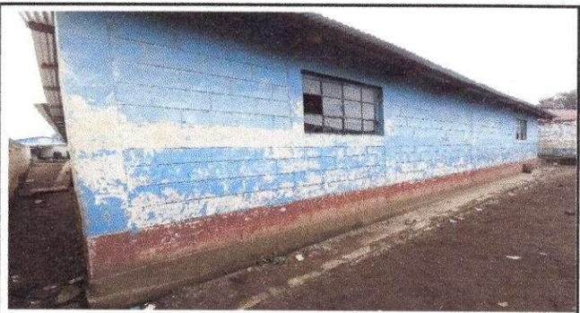
Foto 10: Estado actual de la pintura de paredes de aulas exteriores
