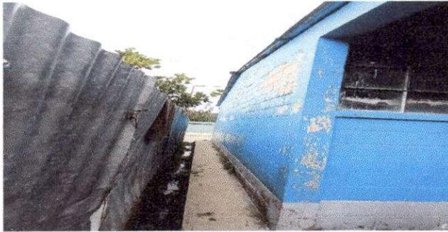
Foto 13: Estado actual de la pintura de paredes de aulas exteriores
