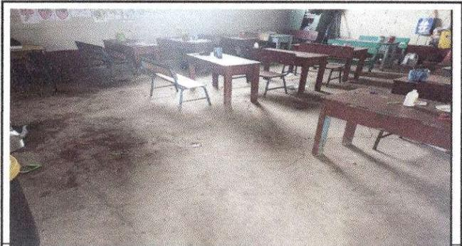
Foto 5: Estado actual piso de torta del aula de Pre-primaria Bilingüe, de 6.90 mts. de largo por 5.75 mts de ancho, igua la 39.675, se aproximó a 40 mts. Cuadrados
