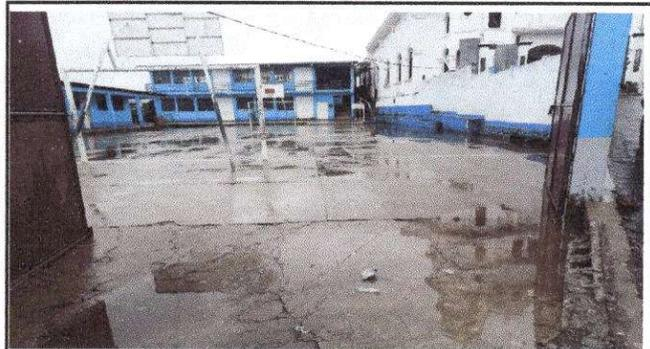
Foto 9: Estado actual de la cuneta donde se reposa agua lado derecho de la cancha de baloncesto
