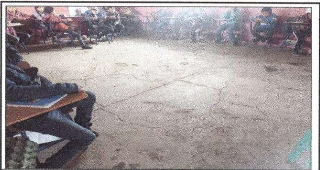
Foto 6: Estado actual piso de torta del aula de Quinto grado primaria sección A, de 6.90 mts. de largo por 5.75 mts de ancho, igua la 39.675, se aproximó a 40 mts. Cuadrados
