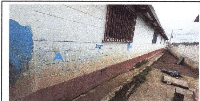
Foto 11: Estado actual de la pintura de paredes de aulas exteriores
